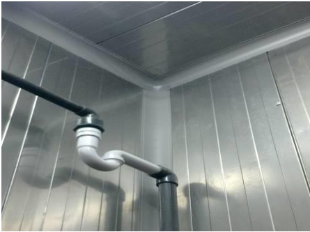
HİJYENİK PVC AKSESUAR UYGULAMASI
